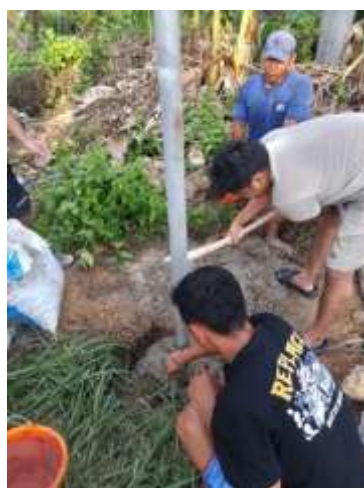
Gambar 2. Proses Pemasangan Convex Mirror
