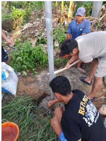
Gambar 2. Proses Pemasangan Convex Mirror.
